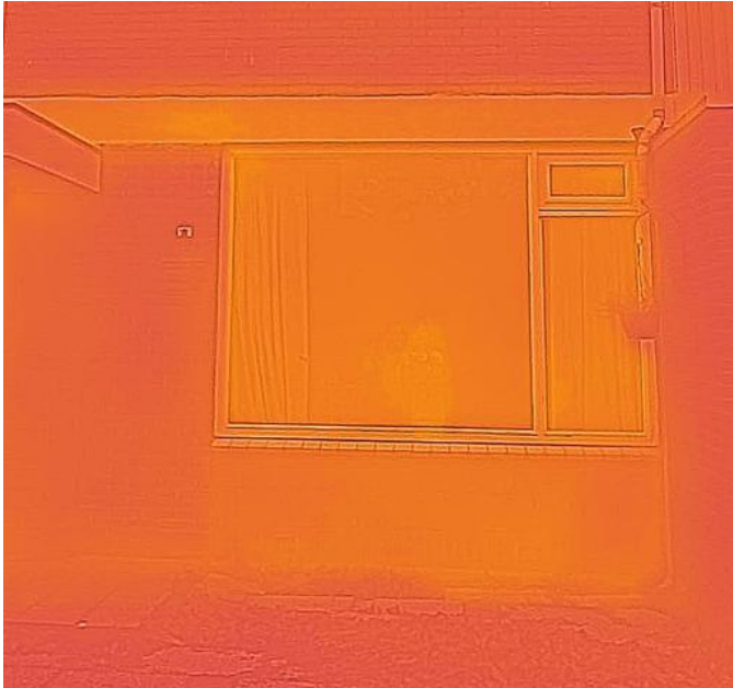
Radiator onder raam
